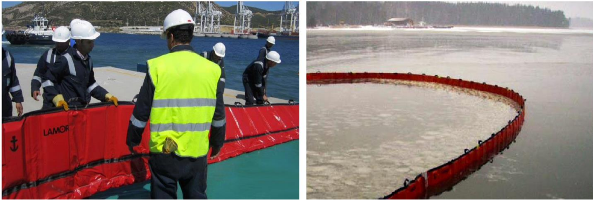
14. ábra: A terelőelem kihelyezés és működés közben.
