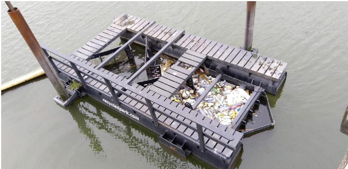
11. ábra: Hulladékgyűjtő csapda Keilehaven-nél, Rotterdamban – cölöpös kikötéssel
